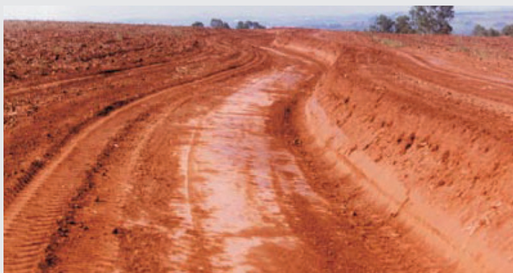
ACABAMENTO EFETUADO COM MOTONIVELADORA
